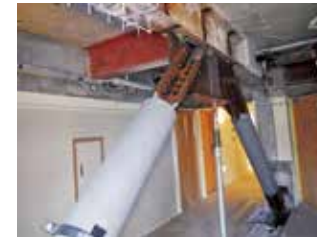
二重鋼管ブレース組立て状況
