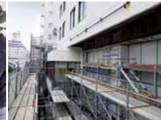
既存カーテンウォール解体後状況 (建物側に仮設壁による止水壁を設置)
